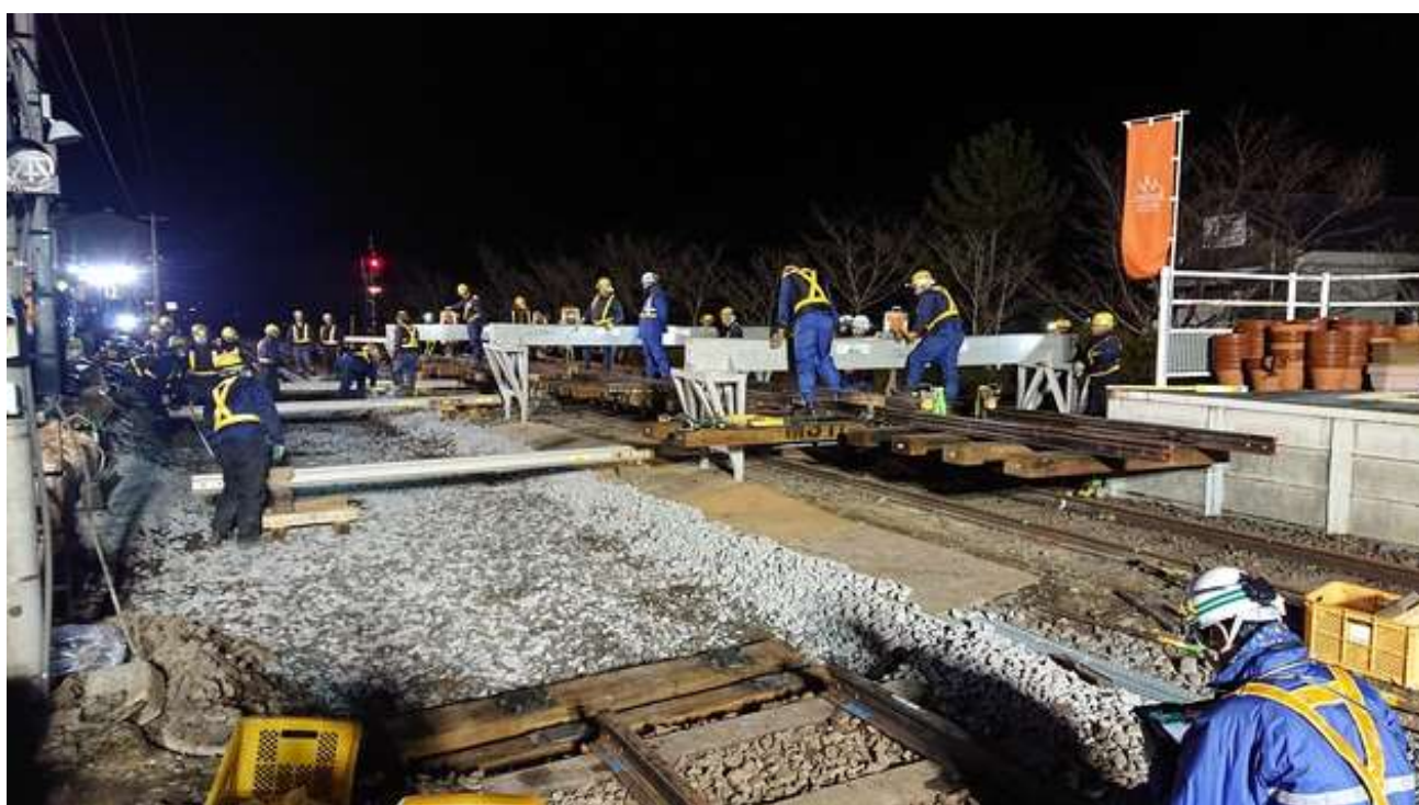
信楽構内分岐器更新工事の様子
